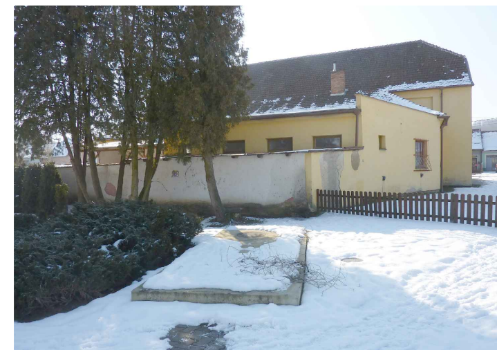
POHLED OD OBEČNÍHO ÚŘADU - Z ANALÝZ A LOGICKÉHO ÚSUDKU VYPLÝVÁ ŽE TENTO POHLED JE ZÁSADNÍ PRO CELÉ ŘEŠENÉ ÚZEMÍ, TEDY I PRO CELOU OBEC. JE ZDE VŠAK PŘÍSTAVBA, KTERÁ SVÝM ESTETICKÝM ANI TECHNICKÝM STAVEM NEODPOVÍDÁ SITUACI. JE EVIDENTNÍ, ŽE PŘÍSTAVBY VZNIKALY V PRŮBĚHU ČASU A JSOU TEDY VELMI NEKVALITNÍM "PŘÍLEPKEM" K BUDOVĚ SOKOLOVNY.
