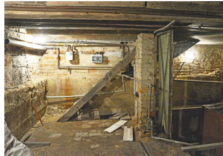
POHLED DO PROSTORU POD PÓDIEM - PROSTOR POD PÓDIEM JE VE VELMÍ ŠPATNĚM STAVU - NÍZKÁ PODCHODNÁ VÝŠKA, VLHKOST, PŘÍSTUP, CELKOVĚ ŠPATNÝ STAVEBNĚ TECHNICKÝ STAV. POZITIVEM JE VŠAK SAMOTNÁ EXISTENCE PROSTORU. V MINULOSTI ZŘEJMĚ VEDLA DO SKLEPU OKNA, KTERÁ JE MOŽNÉ OBNOVIT. PROSTOR TAK MŮŽE BÝT VYUŽÍVÁN JAKO TECHNICKÉ ZÁZEMÍ, KTERÉ BY JINAK ZABÍRALO MÍSTO V RÁMCÍ 1.NP.
