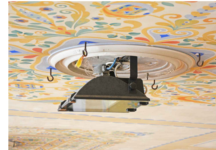
POHLED NA DETAIL STROPU - STROP JE HISTORICKY VYMALOVÁN SLOVÁCKÝMI MOTIVY. JE ZCELA NEVHODNĚ ABY TECHNICKÉ PRVKY, JAKO OSVĚTLENÍ DEVASTOVALY STROPNÍ MALBU.
