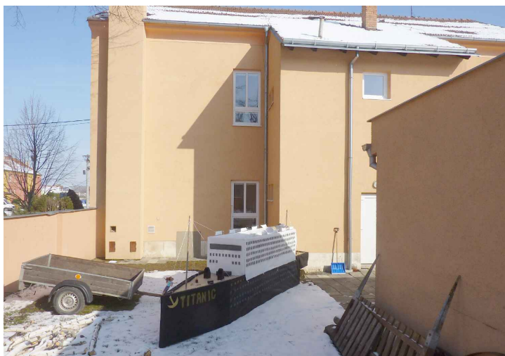
POHLED DO ŠKOLNÍHO DVORA - VZHLEDEM K UMÍSTĚNÍ ŠKOLY JE NEVHODNÉ ABY JEJÍ DVŮR NESLOUŽIL DĚTEM ALE SPÍŠE JAKO TECHNICKÉ ZÁZEMÍ OBCE S GARÁŽÍ A TECHNIKOU. TOTO MŮŽE BÝT USKLADNĚNO NĚKDE MIMO CENTRÁLNÍ PROSTOR OBCE.
