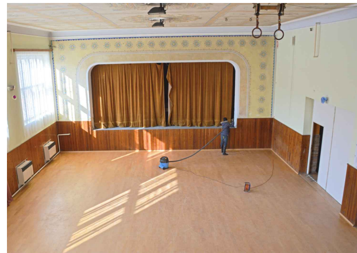
POHLED NA SÁL Z GALERIE - SÁL JE KAPACITNĚ VYHOVUJÍCÍ PRO OBEC SE 700 OBYVATELI. ANALÝZY PROKAZÁLY, ŽE POŘÁDANÉ AKCE, KTERÉ SE ZDE KONAJÍ NEPŘEKRAČUJÍ KAPACITU PROSTORU. V SÁLE JE TŘEBA ŘEŠIT OBECNĚ OBNOVU VŠECH TYPŮ POVRCHU. DÁLE JE NUTNÉ NOVÉ TOPENÍ A CVIČEBNÍ PRVKY VČETNĚ USKLADNĚNÍ.
