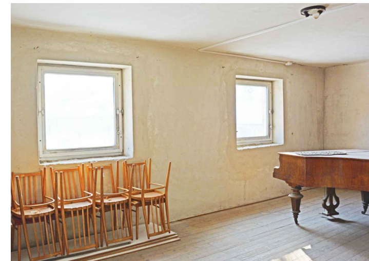
POHLED DO PROSTORU GALERIE - GALERIE VE 2.NP JE POMĚRNĚ VELKORYSÁ, AVŠAK VE ŠPATNĚM STAVEBNĚ TECHNICKĚM STAVU JE PODLAHA, POVRCHY I ZÁBRADLÍ. NEVYHOVUJÍCÍ JE TAKTĚŽ SCHODIŠTĚ, KTERÉ NEVYHOVUJE DNEŠNÍM POŽADAVKŮM. OKENNÍ OTVORY JSOU EVIDENTNĚ DODĚLÁVANÉ POZDĚJI A Z ESTETICKÉHO HLEDISKA JSOU NEVHODNÁ.
