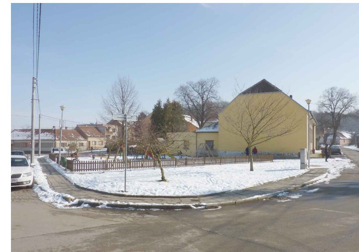
POHLED OD ULICE PETRA KOŠŤÁLA - HISTORICKY ZDE PROTÉKAL NYNÍ ZATRUBNĚNÝ POTOK, A NA NĚJ NAVAZOVALY BUDOVY. TATO SITUACE ZAPŘÍČINILA, ŽE STÍT SOKOLOVNY, KTERÝ BY MĚL LOGICKY TVOŘIT HLAVNÍ PRŮČELÍ, NEBO BY MĚL BÝT ALESPŮŇ NĚJAK ČLENĚNÝ, JE ZCELA PRÁZDNÝ. NÁVRH BY SE S TOUTO OBTÍŽNOU SITUACÍ MĚ VYPOŘÁDAT.
